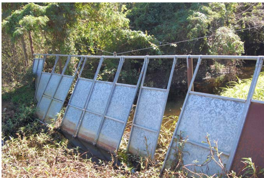
Figure 8 : La balancine ouest du site de Tiéa
