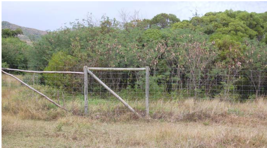
Figure 7 : Clôture avec poteaux en « Pinus traité »
